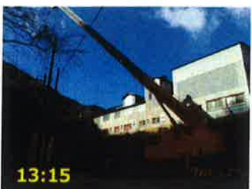
高圧送電盤(発)吊り上げ
