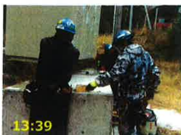
アンカーボルト打込み
