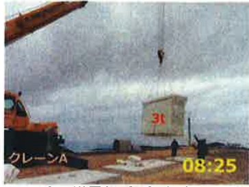
高圧送電盤(発)荷降し
