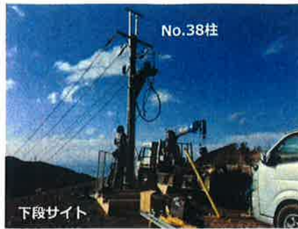
高圧送電線引込み接続工事 ここから高圧送電盤まで埋設になります。
