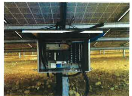
ソーラーケーブル・DC幹線入線作業 ソーラーケーブル入力10回路/台（最大）
