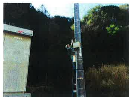
須田さんによるPAS投入操作 <=受電> 無事完了
