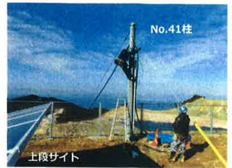
高圧送電線引込み接続工事 ここからNo.3PCS高圧盤まで埋設になります。
