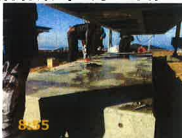
アンカーボルト打込み
