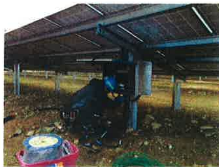
ソーラーケーブル・DC幹線入線作業 ソーラーケーブル入力10回路/台（最大）
