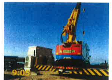
No.3PCS据付完了
