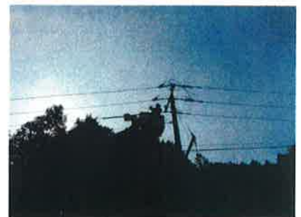
引込送電線接続 (活線作業)
