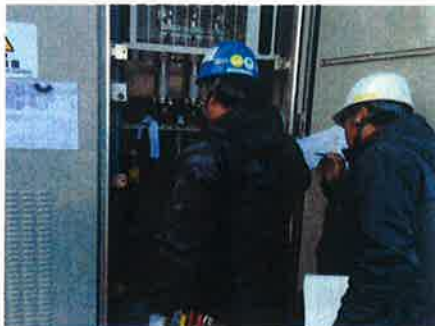
高圧送電線端末処理に立会・指導する 電気主任技術者 須田様(右)
