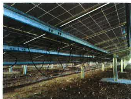
ソーラーケーブルコネクタ接続 隣接するモジュールのケーブルコネクタを1本ずつ接続します。 余長ケーブルは横機に固定、整線します。
