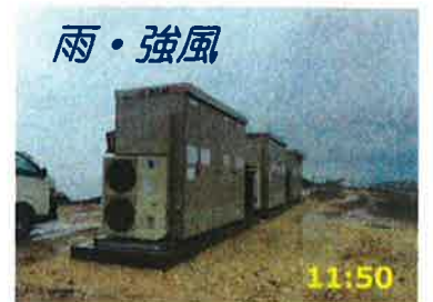
高圧送電盤、PCS荷降し完了
