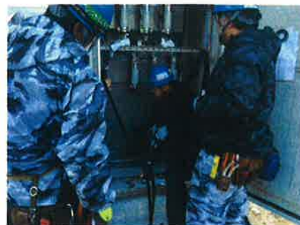
高圧送電線端末処理作業中
