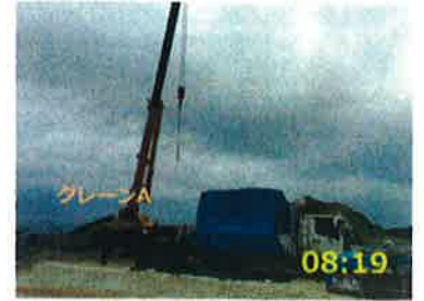
高圧送電盤(発)到着
