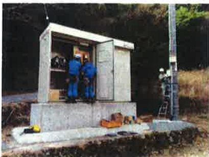
電力計量メータ取付
