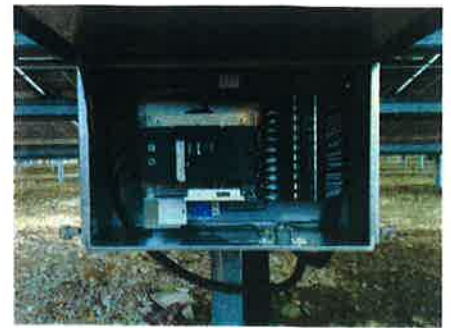
ソーラーケーブルDCB接続 ソーラーケーブル入力10回路/台 (最大)
