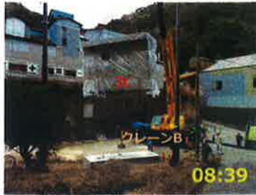
高圧送電盤(送)荷降し
