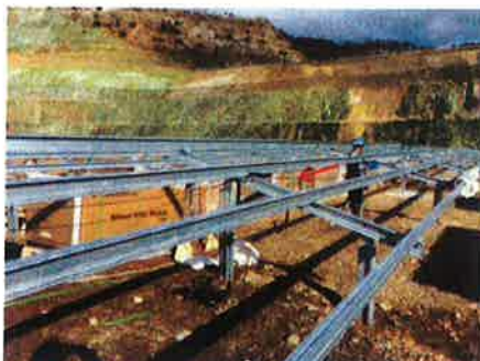
架台横機に沿って ソーラーケーブル敷設作業中
