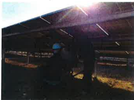
DCB取付作業 上段サイト9台、下段サイト25台
